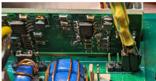
Das Kabel zum Generator wird angesteckt.
